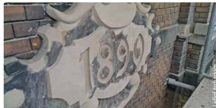
Von den Fachhandwerkern bearbeitetes historisches Fassadenelement
