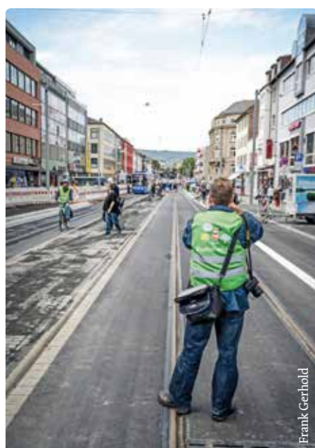
Fast fertig: Blick in den neuen Boulevard
