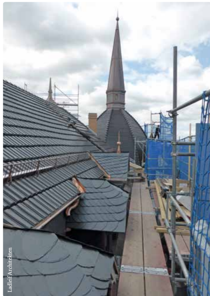
Der Turmaufbau vom Dach aus gesehen
