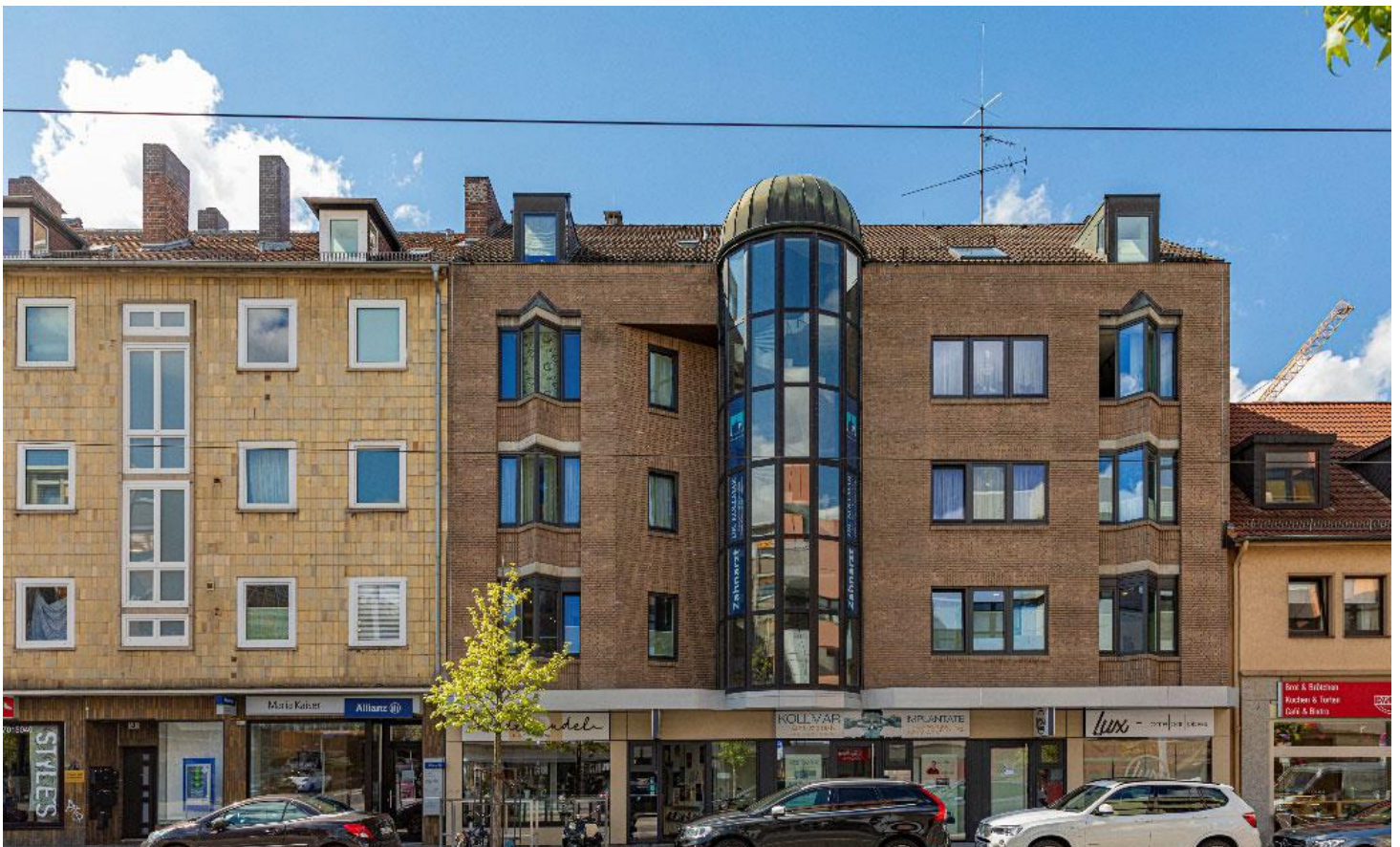
Maßnahme in der Friedrich-Ebert-Straße 55 in Kassel nach der Sanierung
