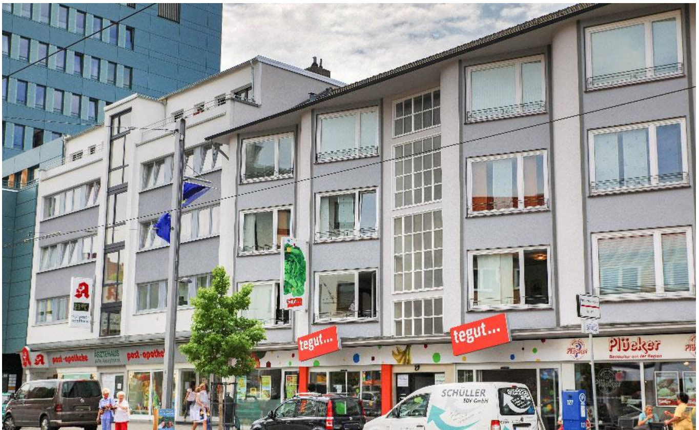
Maßnahme in der Friedrich-Ebert-Straße 29 in Kassel Quelle: Stadtbüro/ Stadt Kassel
