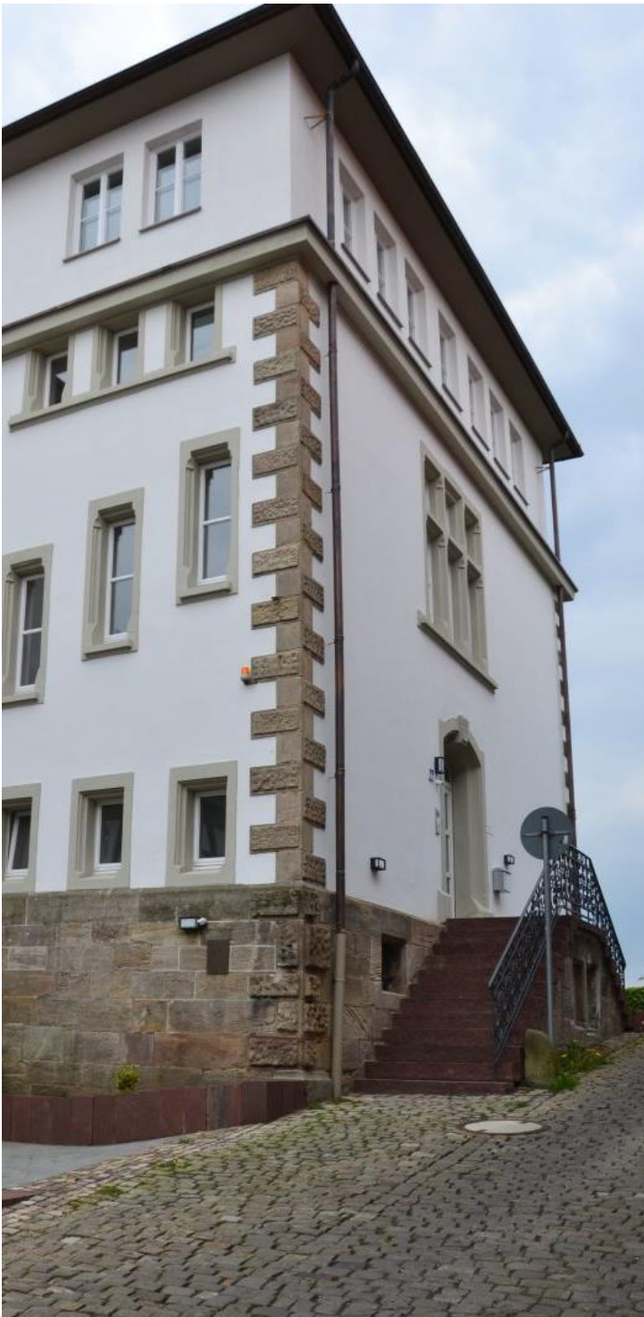
Haupteingang des alten Amtsgerichts. Ein barrierefreier Zugang inkl. Aufzug befindet sich im Hof (Foto: bdks - Baunataler Diakonie Kassel)
