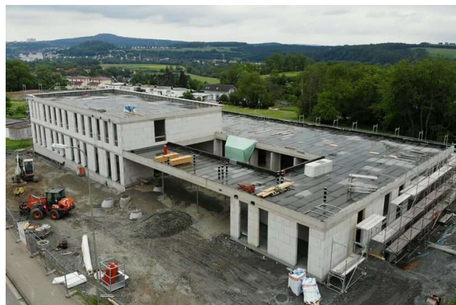
Neubau Kinder- und Familienzentrum KiFaZ Wetzlar-Dalheim (Foto: Pascal Reeber)
