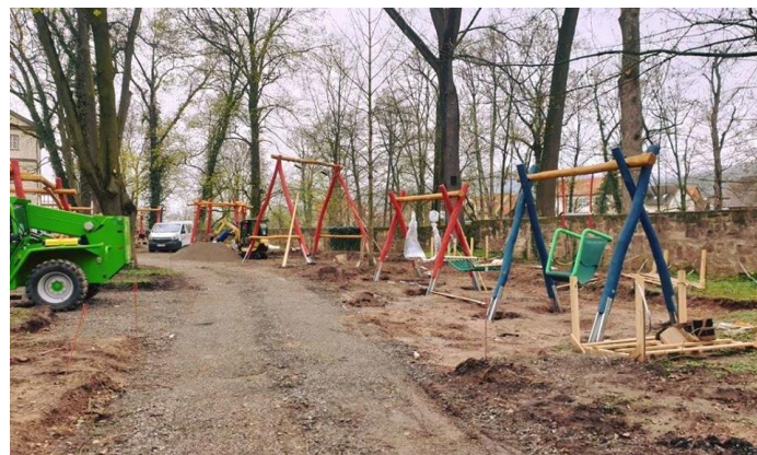
Umbauarbeiten (Foto: MERotenburg)
