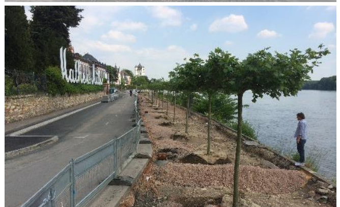
Durchführung der Baumaßnahme (2016)
