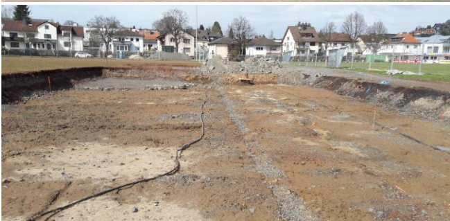
Umbau Sportplatz (Foto: Architekturbüro Göllner)
