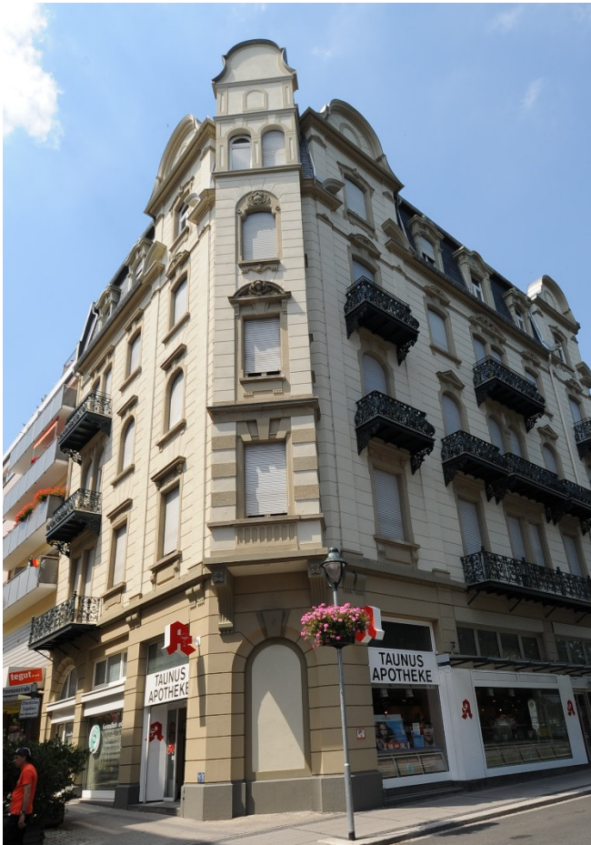
Nach der Sanierung - Kurstraße 9
