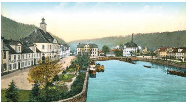
Historisches Bild des Hafenbeckens (Foto: Stadt Bad Karlshafen)
