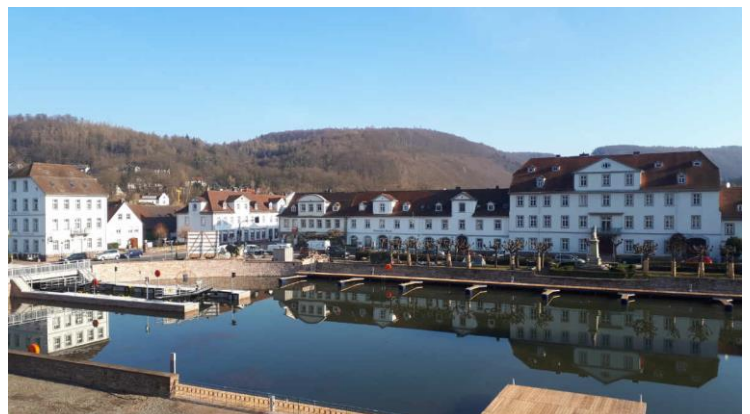
Hafenbecken nach Fertigstellung (Foto: Stadt Bad Karlshafen)
