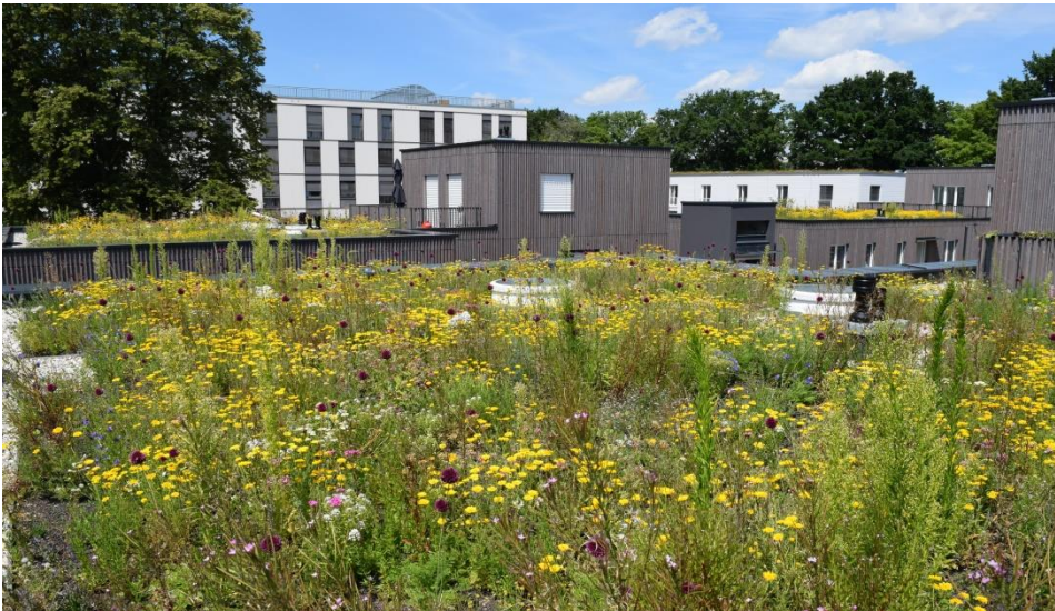
Biodiversdach – Retentionsdach (BUGG – Mann)
