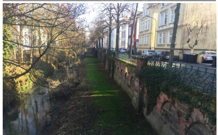
Denkmalgeschützte Mauer entlang der Wieseck (Foto: Universitätsstadt Gießen)
