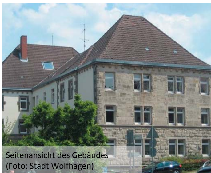
Das Gebäude bleibt im Originalzustand erhal- ten, die Zugänge werden barrierefrei gestal- tet und die Fassade saniert (Visualisierung: Planungsbüro Müntinga und Puy)
