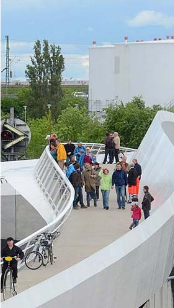
Spaziergänger auf der neu eröffneten Ölhafenbrücke. Foto: NH ProjektStadt
